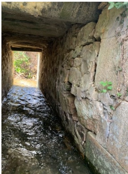
Pont sur le ruisseau de Rongère - route du Canard (Départementale 48A)
