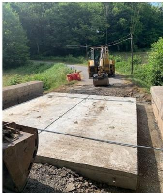
*Dalle béton et fer à béton avec croix de St André pour maintenir les parapets*
